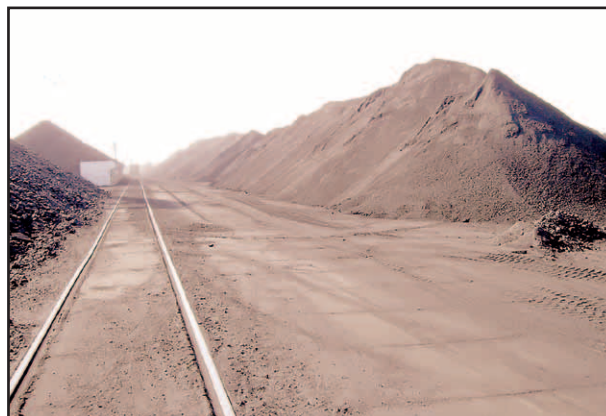
Рис. 5. Железнодорожные пути в переходной зоне причала
